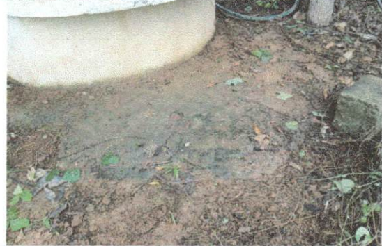
Foto 24: Sustitución de piso de torta de concreto.
