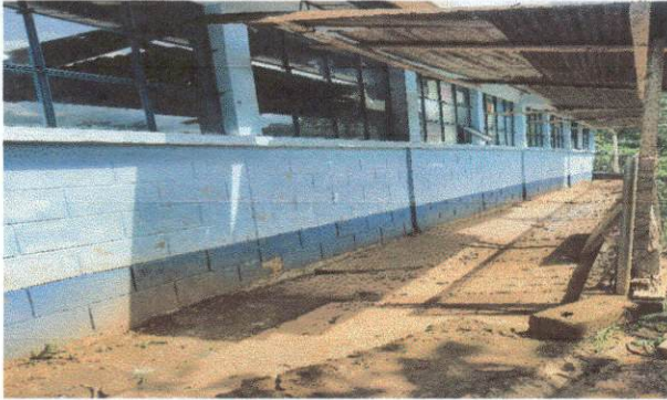
Foto 1: Sustitución de lámina, por lámina broquelada aluzinc calibre 26.
