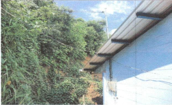
Foto 13: Reparación de cableado eléctrico y sustitución de ducto eléctrico más accesorios.
