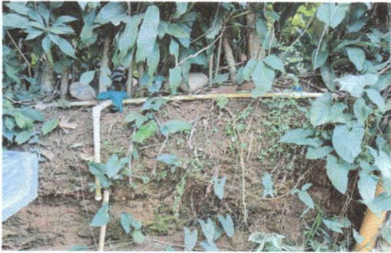
Foto 19: Sustitución de llave de paso.
