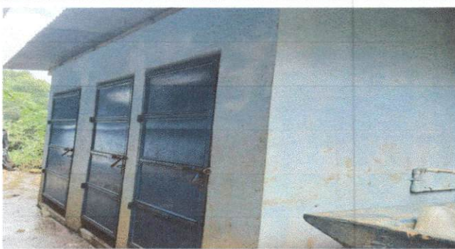
Foto 17: Pintura en muros exteriores e interiores.
