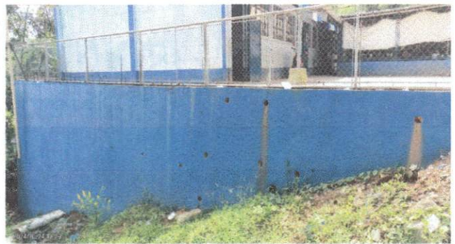
Foto 16: Pintura en muros exteriores e interiores.
