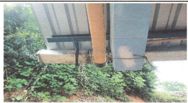
Foto 6: Sustitución de canal de PVC
