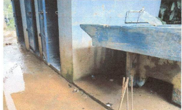
Foto 20: Sustitución de tubería de PVC línea principal de aguas negras.
