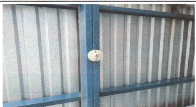
Foto 10: Sustitución de lámparas tipo LED
