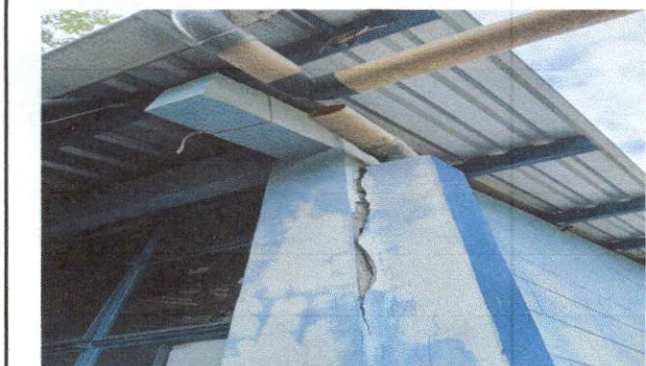
Foto 7: Sustitución de bajada de agua pluvial, tubo PVC 3"
