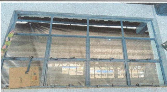
Foto 5: Sustitución de vidrios.
