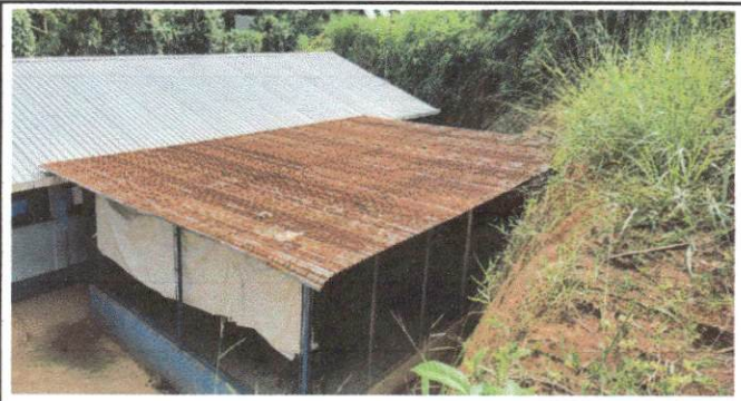
Foto 22: Sustitución de lámina, por lámina troquelada aluzinc calibre 26.
