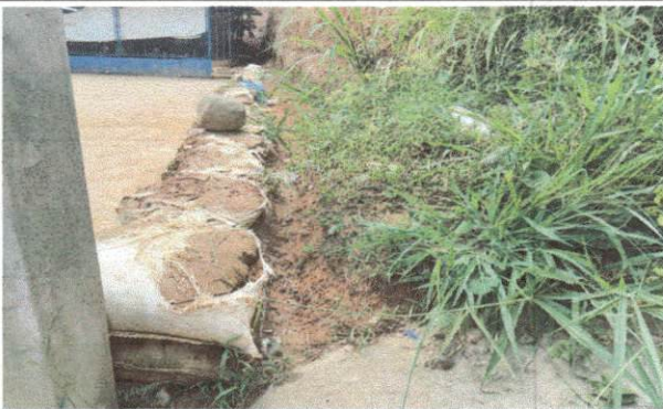
Foto 15: Reparación de cuneta de concreto ancho de 0.60
