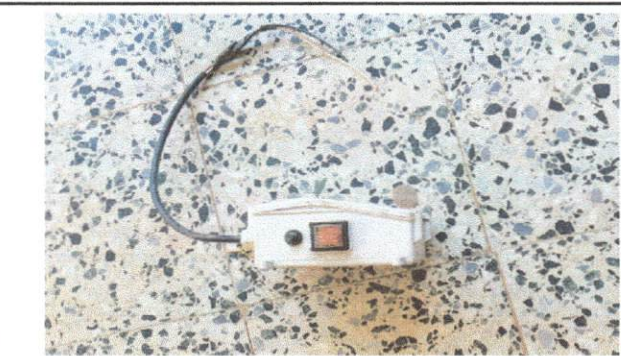
Foto 12: Sustitución de flipones
