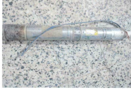
Foto 26: Sustitución de bomba de agua
