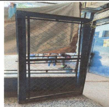
Foto 4: Fabricación e instalación de puertas de metal en módulos
