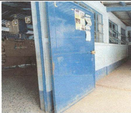
Foto 3: Mantenimiento a estructura (fijado, cambio de tubo, cepillado, sujeciones, aplicación de pintura)
