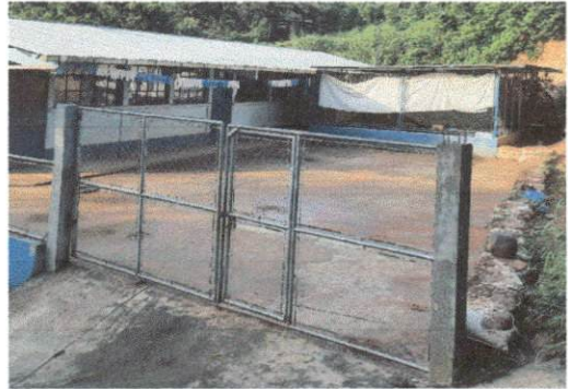
Foto 14: Fabricación e instalación de portón de metal de ingreso
