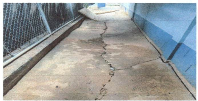
Foto 8: Reparación de banquetas de concreto
